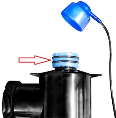
Desatornille la manga de cuarzo azul girando la tuerca de bloqueo en sentido antihorario. Deben desatornillarse ambos extremos antes de que pueda retirarse la manga de cuarzo.
