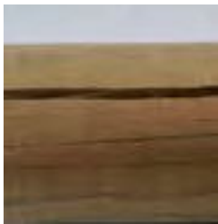
Cracks/Grietas/Fente/Risse/ Crepe/ Barsten/Fendas
