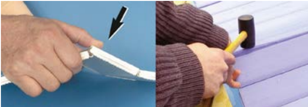
Figure 45 – Acoplamiento de láminas
