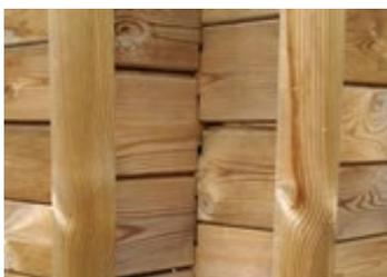
Monte un perfil de acabado en cada extremo de las paredes. Para hacer esto, use 3 clavos de cabeza convexa de 2,8 x 60: uno en la parte superior, uno en el medio y uno en la parte inferior de cada extremo. Asegúrese de que los clavos estén en el centro de las tablas de la pared para evitar que estallen.
