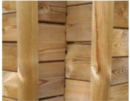
Figura 61 – Principio de ensamblaje de las láminas de madera
