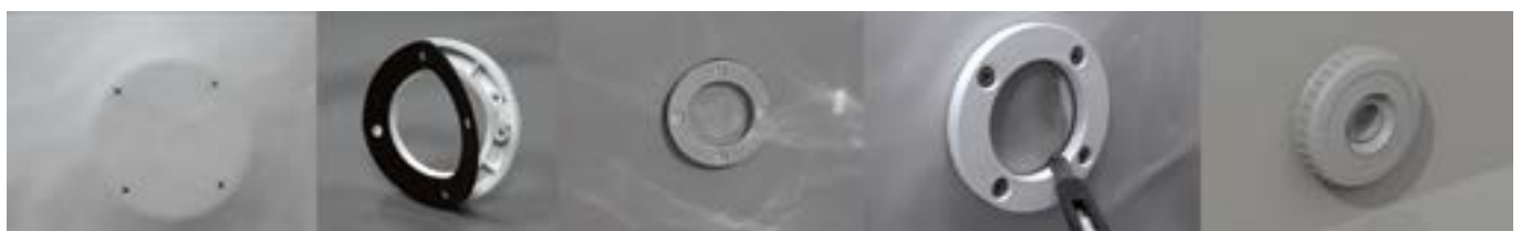
Figure 35 – Montaje de la brida sobre el retorno
