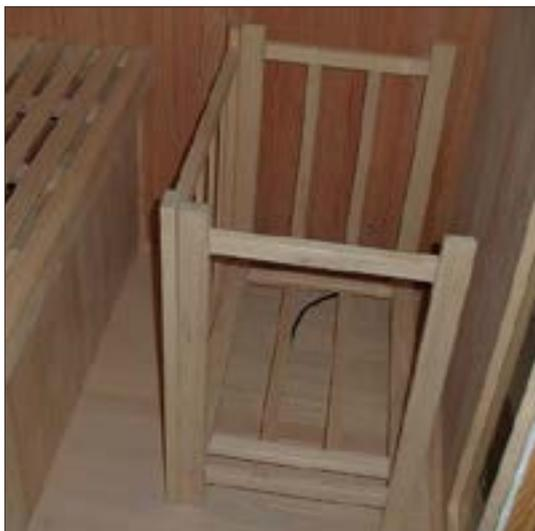
Debe colocar la cubierta de protección del calentador antes de instalarlo en el interior de la cabina.
