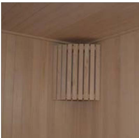
Fije las luces en los rincones de la cabina y conéctelas a la alimentación del calentador eléctrico.
