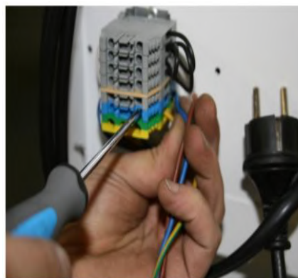
5 Conecte los cables de alimentación y cualquier humidistato remoto.
