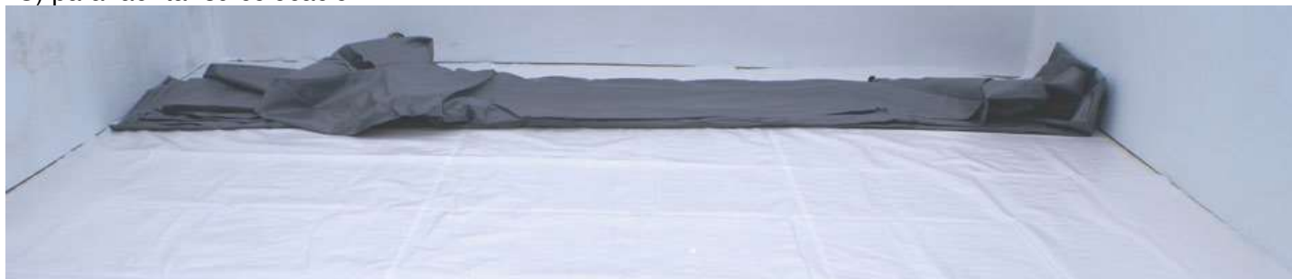
Figura 21 – Despliegue del revestimiento
