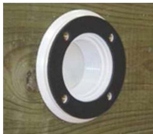
Figura 19 - colocación de la junta
