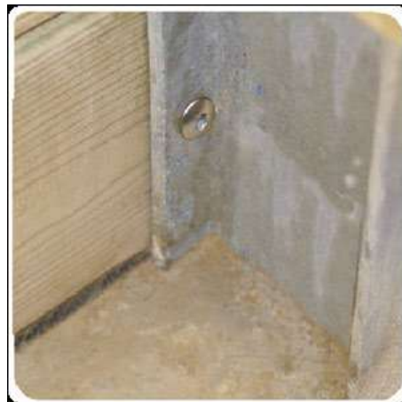
Figura 8 – Bloqueo de los tablones en los puntales metálicos
