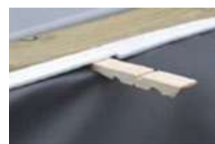
Figura 22 – Bloqueo del revestimiento con pinzas de la ropa
