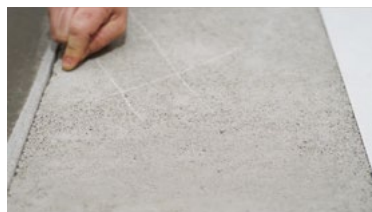
SOLERA DE COLOCACIÓN CEMENTOSA comprobación dureza y limpieza
